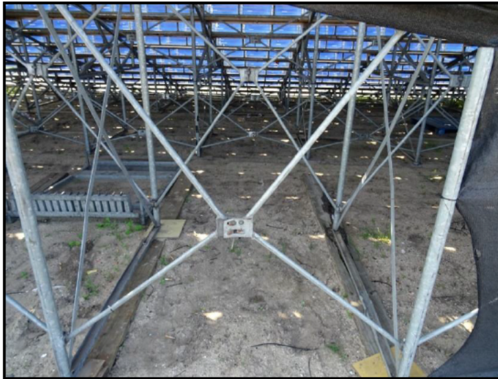
Figuur 10. Onderzijde van de tribune.
