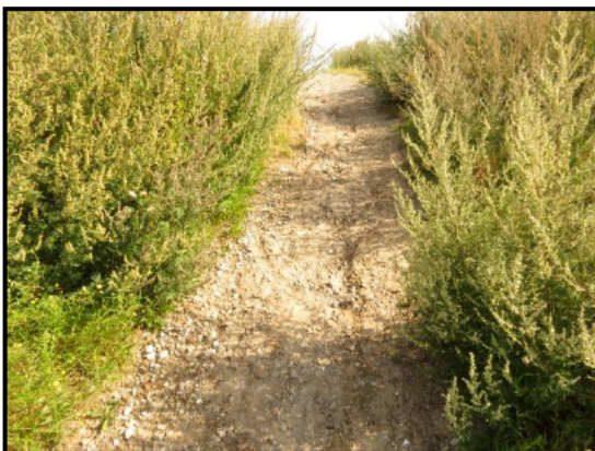
Figuur 4. Eindgedeelte van het te verstevigen pad, dit gedeelte van het pad bestaat voornamelijk uit een verharde ondergrond met stenen en fijn puinmateriaal.
