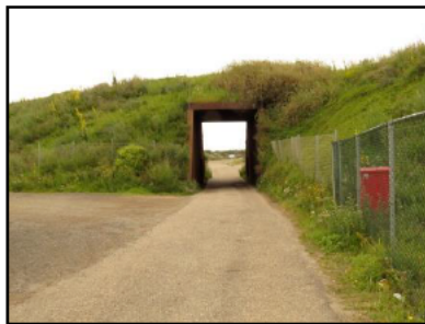
Figuur 42. Zicht op de bestaande toegang van het onderhoud pad.
