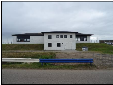
Figuur 45. Zicht op het te slopen restaurant.
