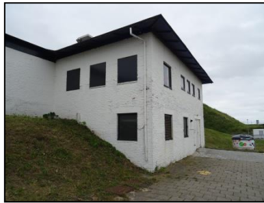
Figuur 46. Detail foto van het gebouw.
