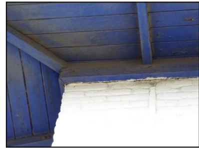
Figuur 47. Detail foto van de daklijst.
