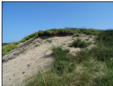
Figuur 32. Zicht op zuidelijk geëxposeerd zandig talud.
