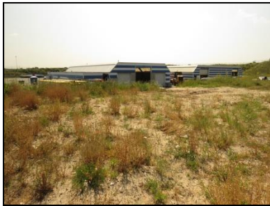
Figuur 53. zicht op de onderzoekslocatie (berm), foto richting het noordoosten.
