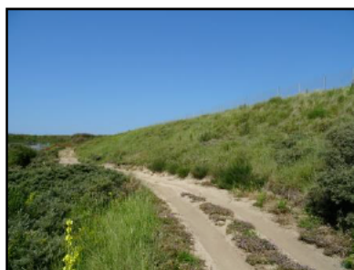
Figuur 38. Zicht op zuidelijk geëxposeerd talud.
