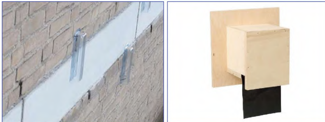
Figuur 3.18 Voorbeelden van bestaande exclusion flaps van Unitura (links) en van Vivara Pro (rechts)
