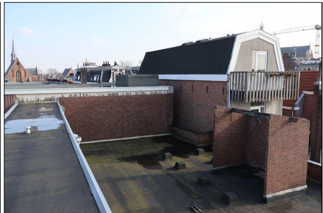
Figuur 5. Dak en betimmering voorzijde
