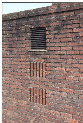
Figuur 10. Detail van beluchtungskanaal
