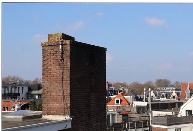
Figuur 9. Beluchtungskanaal op achterzijde dak
