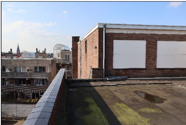
Figuur 4. Dak en betimmering achterzijde
