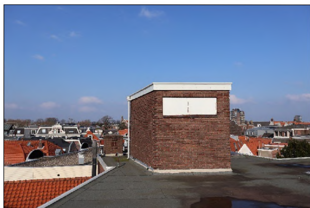
Figuur 12. Liftschat bebouwing achterzijde dak
