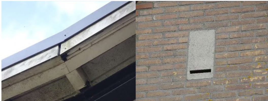
Figuur 3.4 Opening in daklijst (links) en inbouwkast voor vleermuizen (rechts) in deelgebied 2
