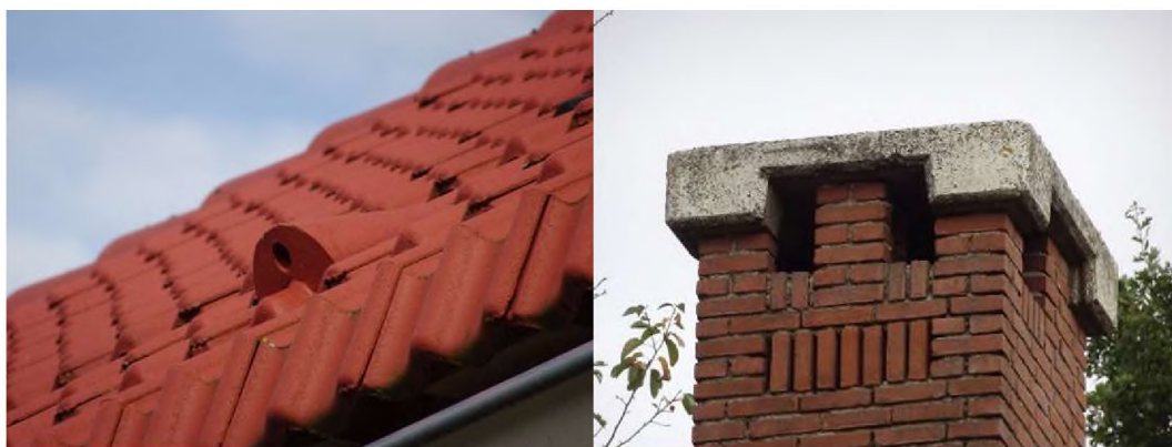
Figuur 3.17 Vogeldakpan in deelgebied 2 (links) en nissen in schoorsteen in deelgebied 3 (rechts) geschikt voor huismus
