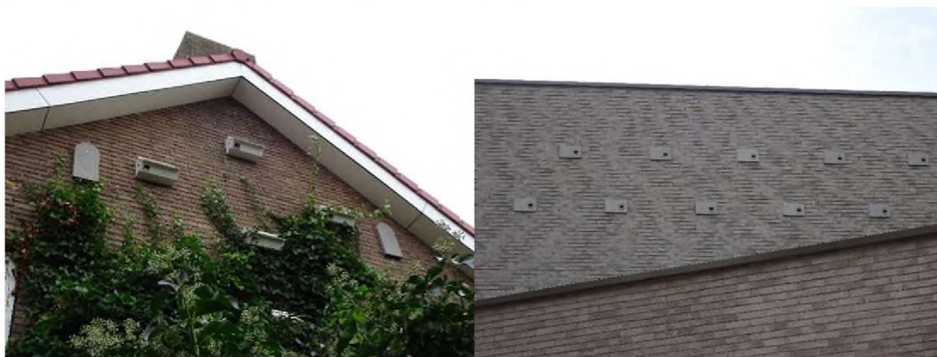
Figuur 3.20 Gierwaluwkasten en vleermuiskasten in cluster 2U (links) en ingebouwde gierwaluwstenen in 2Y (rechts). Deze voorzieningen voor gierwaluw zijn zowel voor huismus als voor gierwaluw geschikt
