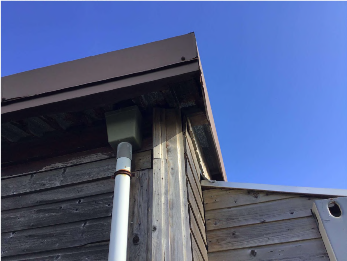
Afbeelding 16: Opening onder de dakrand.
