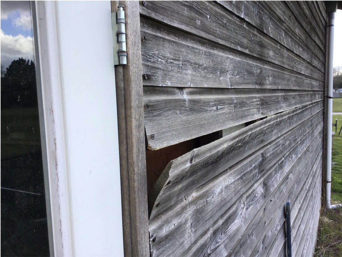
Afbeelding 14: Losse plank die toegang geeft tot de ruimte tussen de muur.
