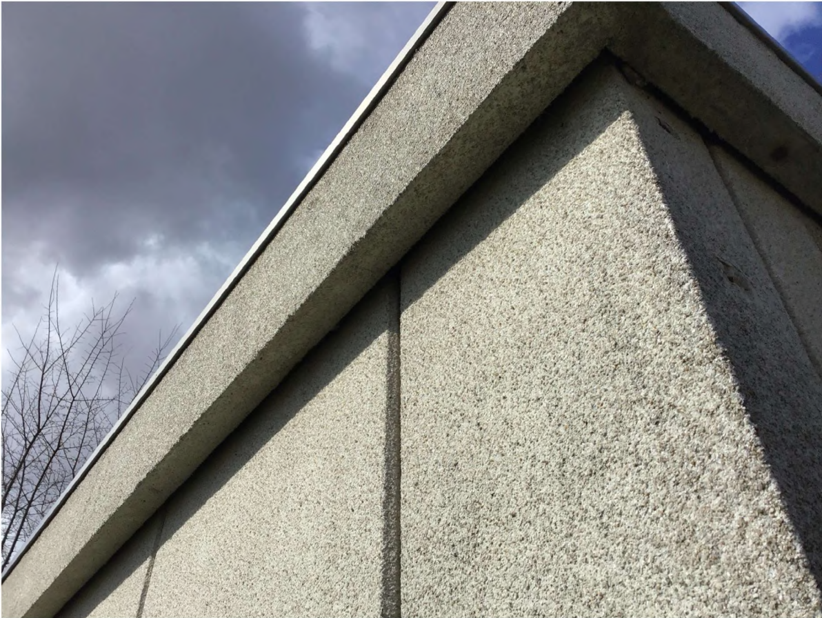
Afbeelding 39: Spleet tussen de muur en dakrand.
