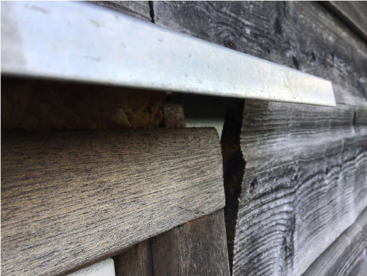
Afbeelding 15: Losse plank die toegang geeft tot de ruimte tussen de muur.
