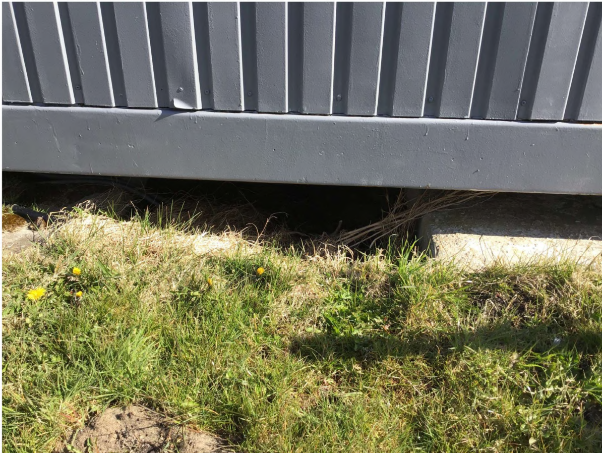
Afbeelding 17: Ruimte onder de aanbouw van het restaurant.
