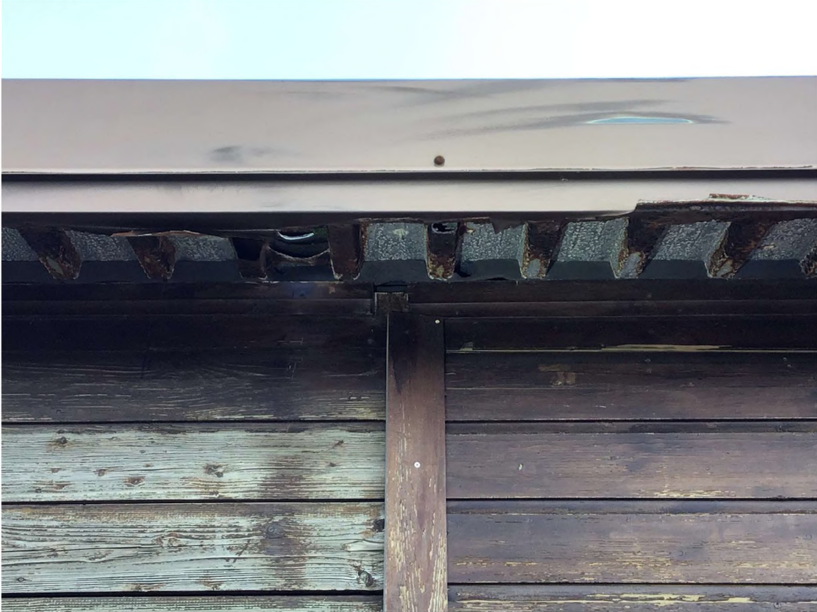
Afbeelding 11: Opening onder de dakrand.
