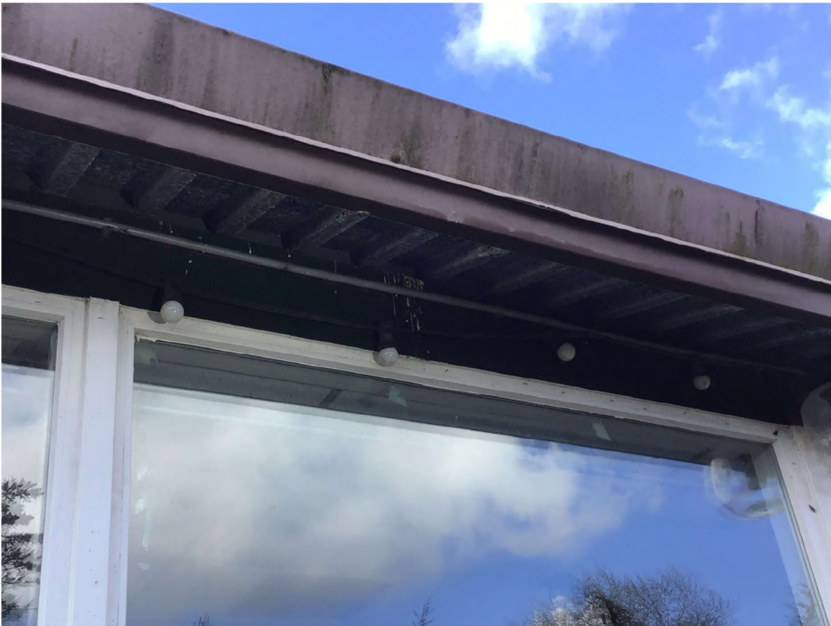
Afbeelding 7: Opening onder de dakrand.
