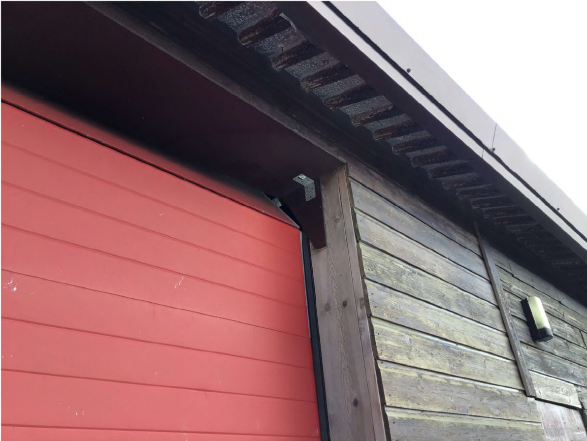
Afbeelding 12: Ruimte bovenaan de roldeur waardoor een opening naar de garage ontstaat.
