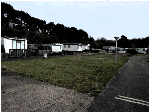
Figuur 1 Overzicht noordgrens vakantiepark
