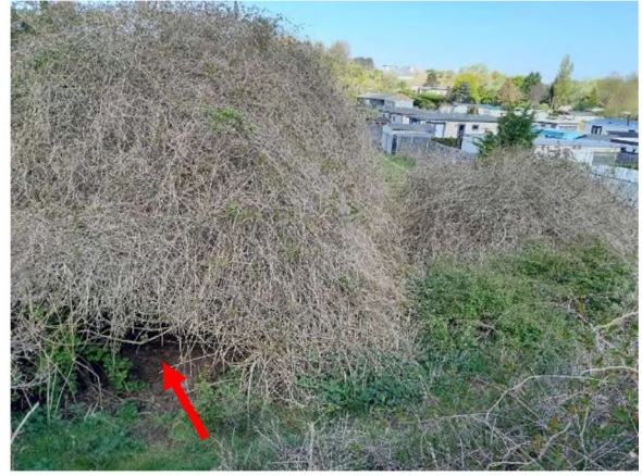
Afbeelding 17: locatie cameraval 1 onder struik op helling oostelijk talud.
