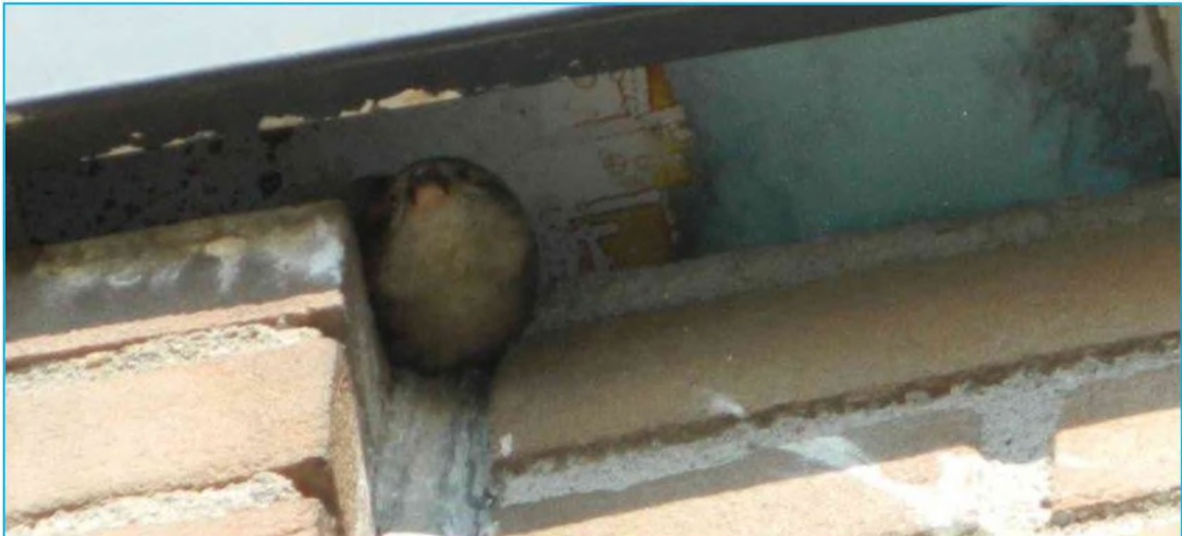
Foto: Huismus broedt in de ruimte onder vensterbank.
