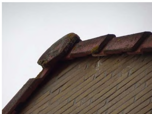
Figuur 3.7 Voorbeeld van overstekende kantpannen en nokpan
