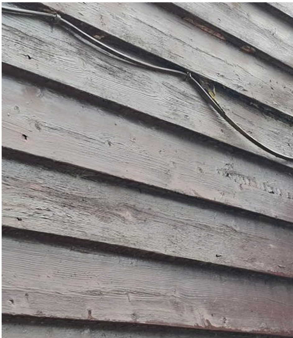
Figuur 3.2 Naadloze aansluiting van houtenpanelen van de stal
